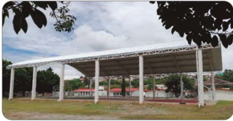
Fotografía 56. Cancha Techada de Usos Múltiples
